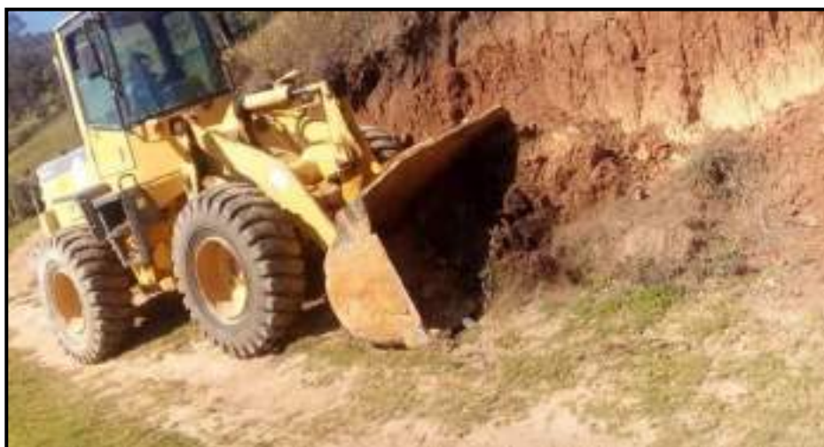
Foto 40: Mantenimiento Tramo Lanchez - La Alfajilla
