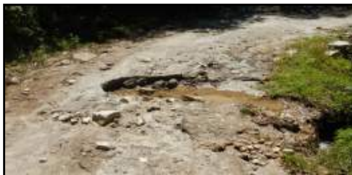
Foto 11: Ruta R0611113 El Molino - Plataforma de vía.
