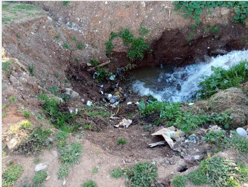
Figura 12 : Punto Crítico ubicado en el canal San Gregorio – Distrito Unión Agua Blanca
