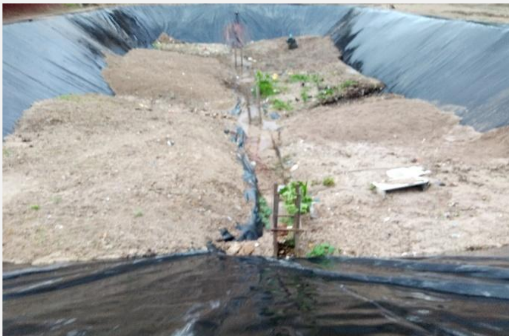
Figura 24 : Trincheras donde se realiza la disposición final de residuos sólidos – Distrito Tongod
