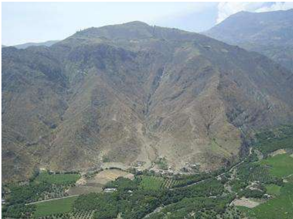
Figura 44. Torrenteras afectadas por donde discurren huaycos de manera excepcional, se asientan viviendas en los depósitos de huaycos antiguos, San Luís, Unión Agua Blanca (INGEMMET, 2009).
