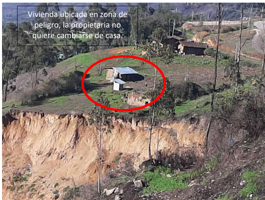
Zona: carretera a Chilete en las coordenadas (9224141.00 m S y 737080.00 m E).
